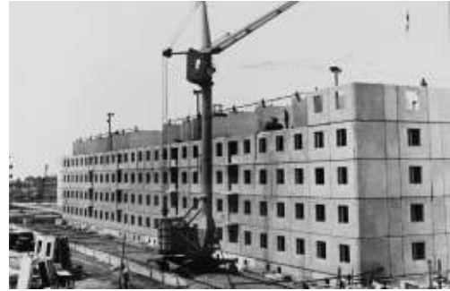
Строительство пятиэтажного жилого дома. Город Волжский
