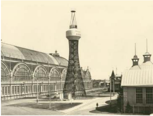
Гиперboloидная башня. Инженер В. Г. Шухов
